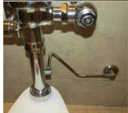
Flush valve trap seal primer
